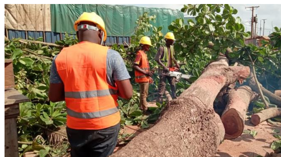
Libération de l'emprise des travaux à Grand-Popo
