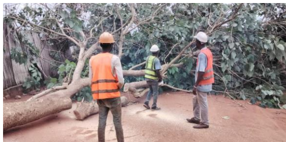
Libération de l'emprise des travaux à Comè
